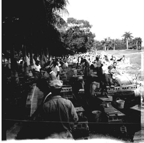
Escuela de bóvedas tabicadas en los terrenos del campo de golf. Archivo Oficina del Historiador de la Ciudad
